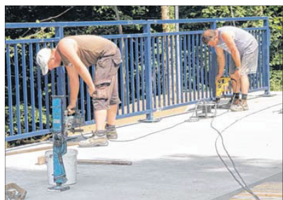
Kurz vor der Freigabe wurde noch das Geländer der Gloinebachbrücke ordentlich befestigt. Fotos (2): Bettina Schütze
